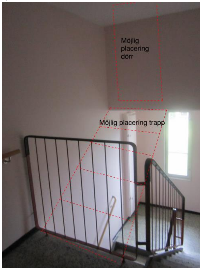
Figur 22: Eventuell möjlig placering av nytt fläktrum för FTX aggregat, 1st per huskropp
